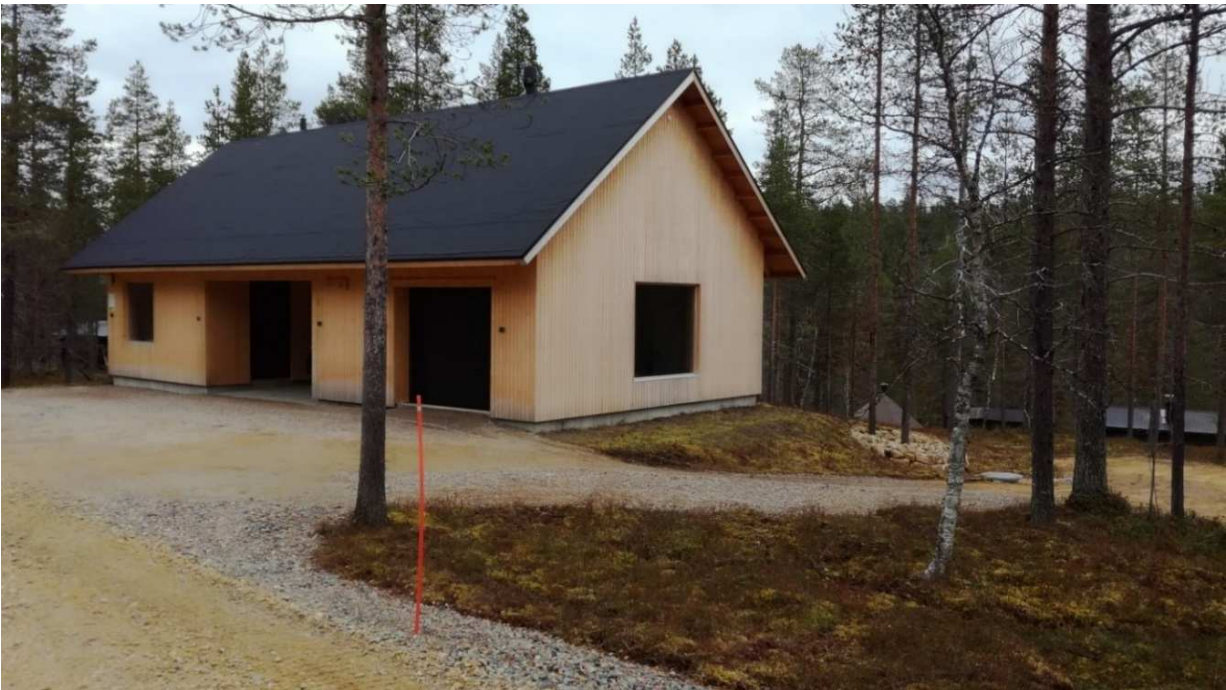
Uutta rakennuskantaa Viskitien varressa.
