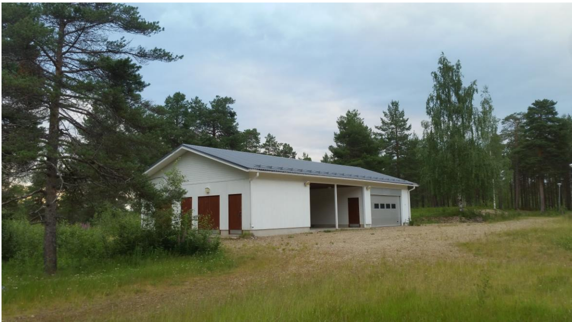
Kuva 14. Vartiorakennuksen läheisyydessä sijaitsee 2000-luvun alussa toteutettu kylmäajoneuvosuoja. Kuva H.Saviharju.
